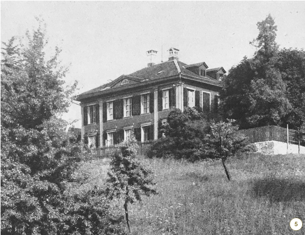
5 Zweiter Standort seit 1928 im geräumigen Haus mit Umschwung auf der Hubelmatt
